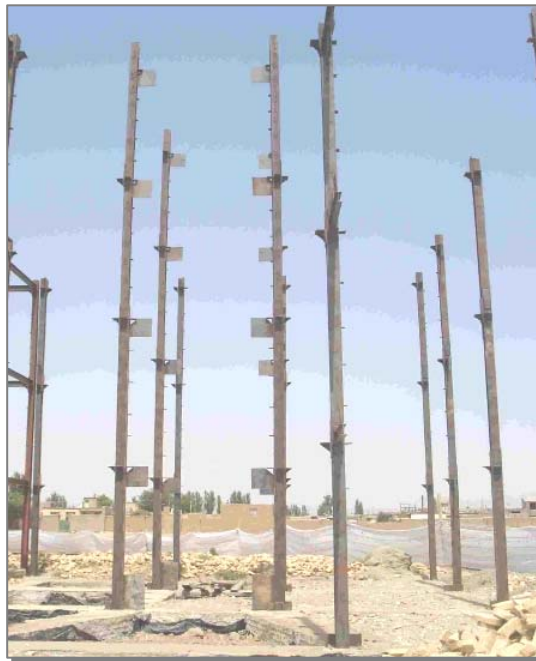
شکل ۱۳-۴- ستونها بدون هیچگونه ساپورتی به حال خود رها شده‌اند. احتمال بروز خطر زیاد می‌باشد.
