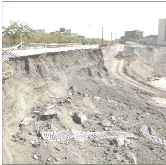
شکل ۱۱-۲- ریزش دیواره و خسارت به خیابان مجاور
