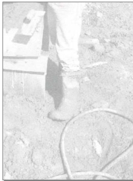
شکل ۴-۱۰- استفاده از نیمه چکمه لاستیکی هنگام کار با محصولات سیمانی
