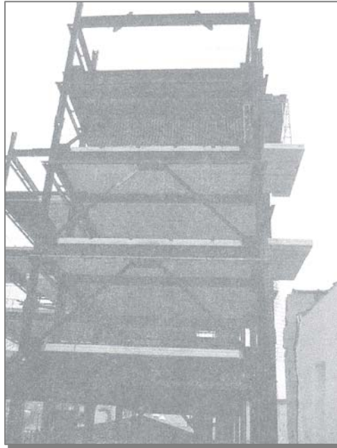
شکل ۱۴-۱- قرار ندادن نرده یا محافظ مناسب در فضای باز طبقات برای جلوگیری از سقوط
