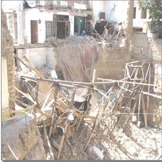
ب- عدم محاسبه و اجرای صحیح سازه نگهدارنده
