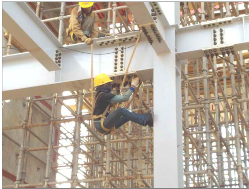
شکل ۴-۱۲- استفاده از وسایل حفاظتی در مرحله برپا کردن اسکلت فلزی.
