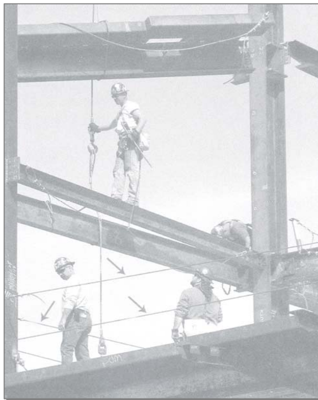
شکل ۱۴-۲- نصب کابلهای ایمنی جانبی یا نرده برای محافظت، بلافاصله پس از نصب کفها
