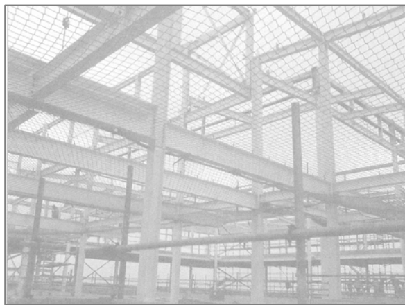
شکل ۱۳-۳- پوشاندن سطح کف طبقات با استفاده از توری‌های ایمنی هنگام نصب اسکلت
