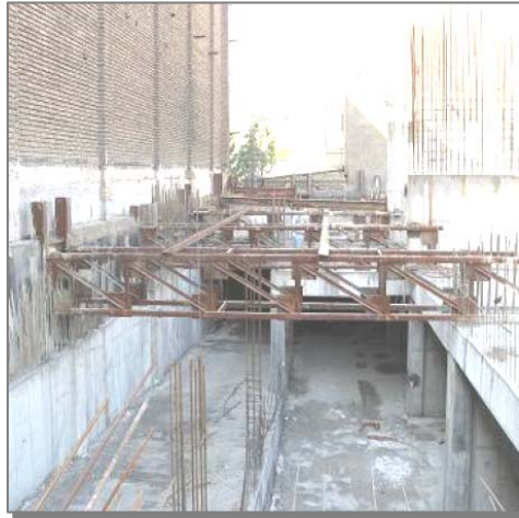
شکل ۱۱-۳- نمونه‌ای از مهار متقابل در گودبرداری
