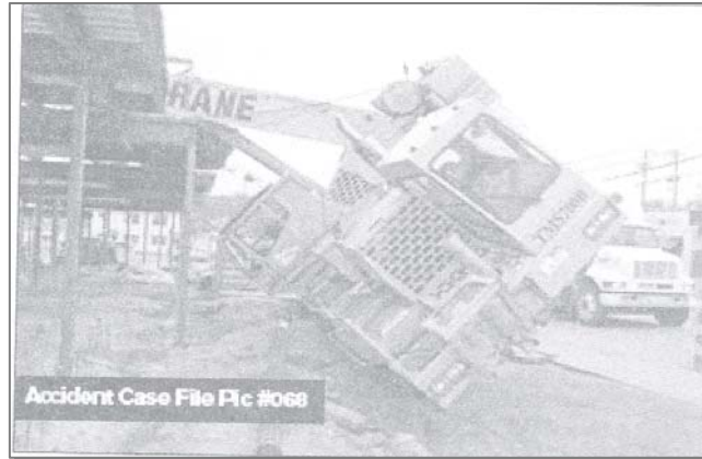
شکل ۱۰-۱- واژگونی جرثقیل در اثر عدم استفاده از جک‌های جانبی
