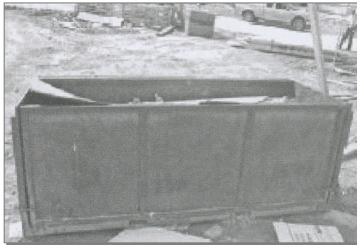
شکل ۱-۲- قرار دادن جعبه‌هایی برای جمع‌آوری مواد زائد در کارگاه.
