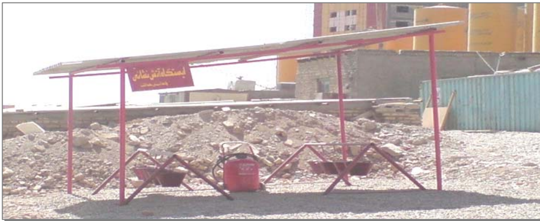
شکل ۷-۲- مسئولان این کارگاه در زمینه استقرار سیستم مدیریت ایمنی و بهداشت، جهت موارد اضطراری با ایجاد ایستگاه آتش نشانی و موارد مورد نیاز، از این لحاظ نیز کارگاه را ایمن ساخته‌اند.
