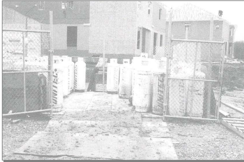
شکل ۱۶-۳- محل محصور شده و مناسب برای نگهداری سیلندرها
