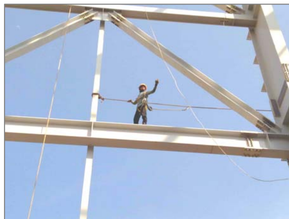
شکل ۴-۳- استفاده از طناب نجات افقی و عمودی
