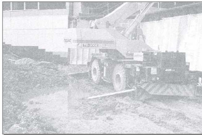
شکل ۱۰-۵- نامناسب بودن خاک زیر جک‌ها
