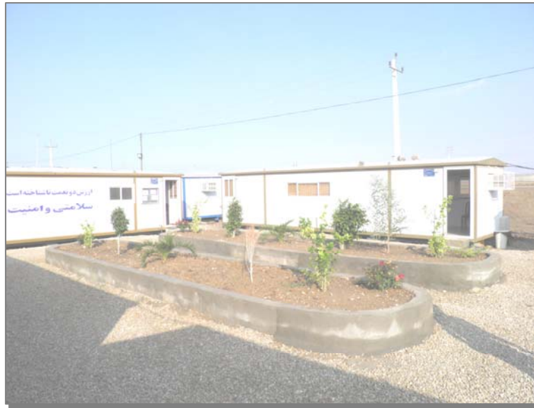
شکل ۱-۳- ایجاد محلی مناسب به عنوان دفتر کارگاه در سایت پروژه.
