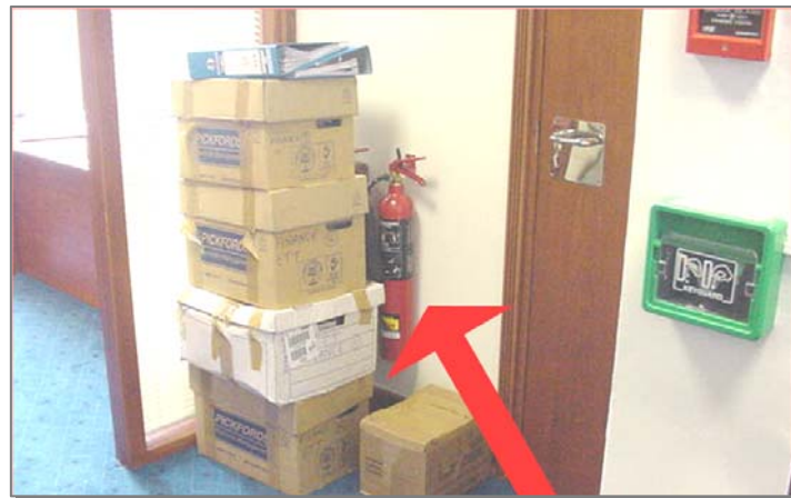
شکل ۷-۴- مخفی شدن کپسول آتش‌نشانی.
