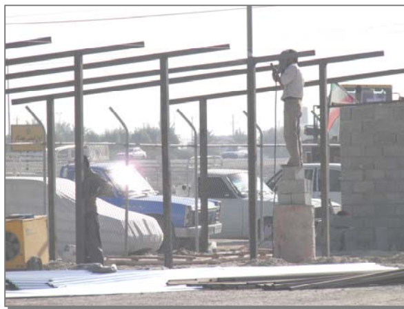
شکل ۱۳-۵- انجام مراحل جوشکاری و برپا کردن اسکلت بدون توجه به مسائل ایمنی.
