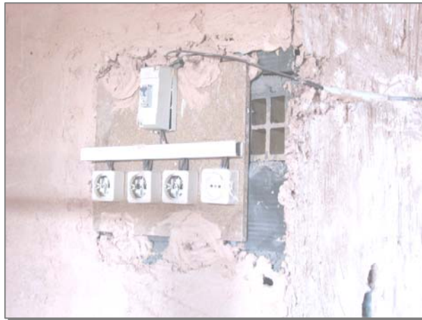
شکل ۵-۲- نصب تعداد کافی کلید و پریز در نقاط مختلف کارگاه برای جلوگیری از ازدیاد و پراکندگی سیم‌های آزاد و متحرک.
