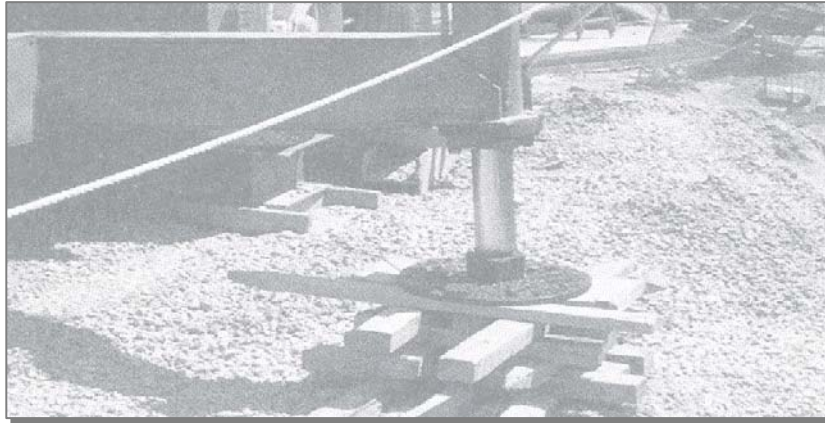
شکل ۱۰-۷- عدم وجود فاصله بین قطعات برای توزیع بار
