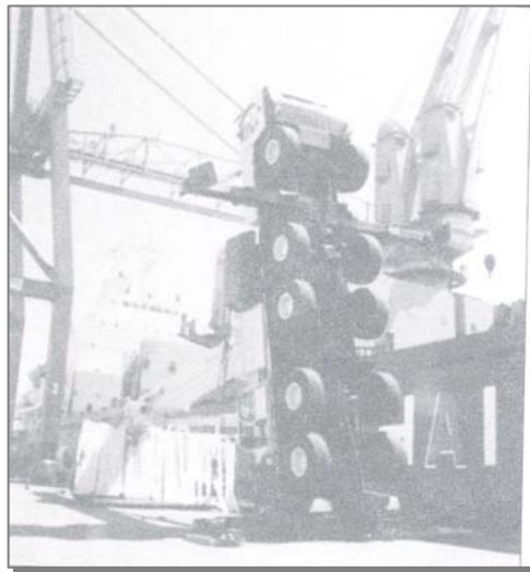
شکل ۱۰-۲- واژگونی جرثقیل در اثر اضافه بار
