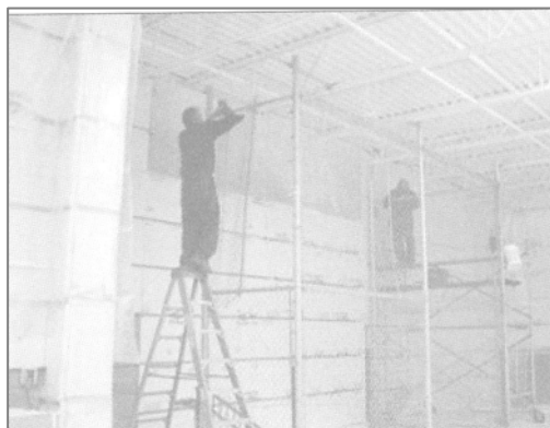
شکل ۱۸-۳- هرگز بر روی تاج نردبان‌های متحرک و تاشو نایستید.
