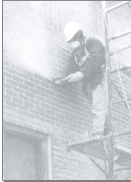
شکل ۴-۷- استفاده از ماسک، عینک و پوشاندن سر و گوش در محیطهایی که گرد و غبار زیاد است.
