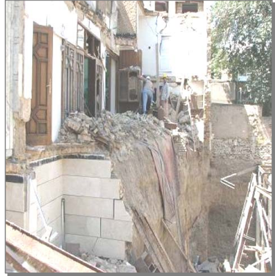
الف- تخریب کلی سازه مجاور گود
