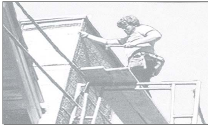
شکل ۱۸-۹- احتمال سقوط فرد در اثر نامناسب بودن داربست وجود دارد.
