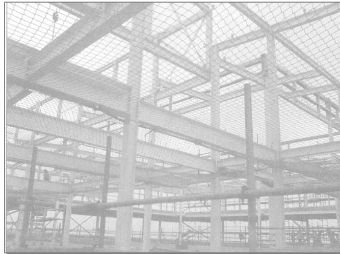
شکل ۱۴-۴- نصب توری‌های ایمنی در جاهایی که امکان نصب نرده‌های حفاظتی وجود نداشته باشند.
