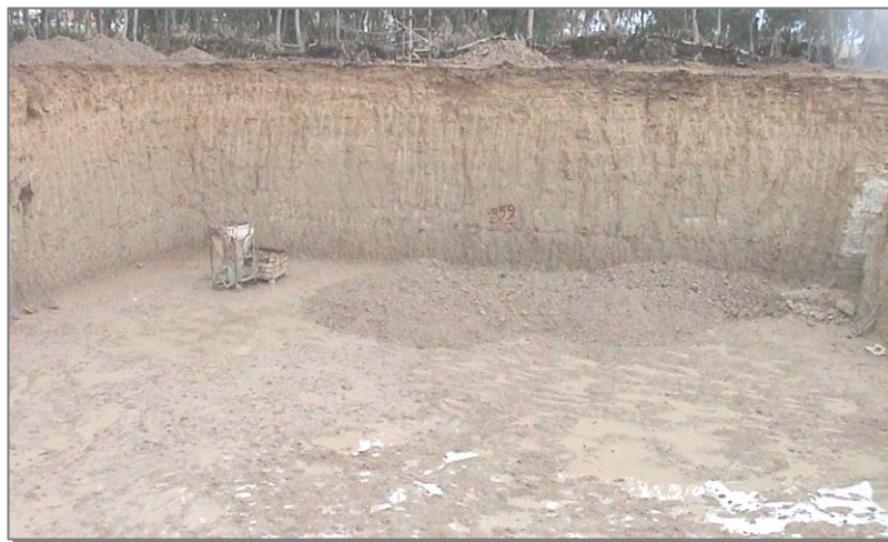
شکل ۱۱-۴- گودبرداری بدون حفاظت
