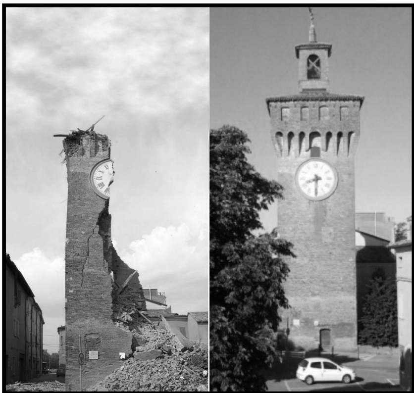
شکل ۴-۷۰- برج ساعت شهر فینال امیلیا که در زلزله‌ی ماه مه ۲۰۱۲ در شمال ایتالیا خراب شد. (تلگراف، ۲۰۱۲)
