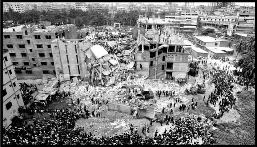
شکل ۳-۸- فروریختن ساختمان راناپلازا در بنگلادش (گاردین، ۲۰۱۳)
