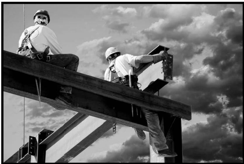
شکل ۴-۵۱- جوشکاری اسکلت فلزی در ارتفاع
