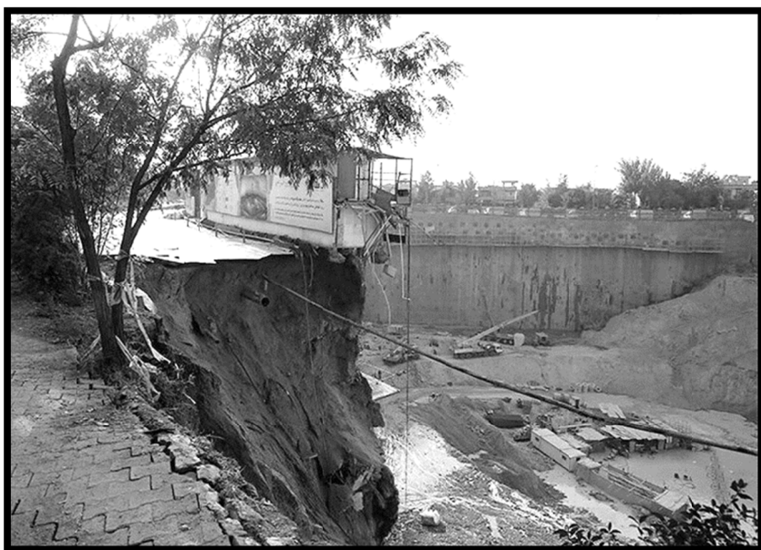
شکل ۳-۷- ریزش گود موقت پروژه‌ی تجاری در تهران. (عکس: تسنیم، ۱۳۹۲)
