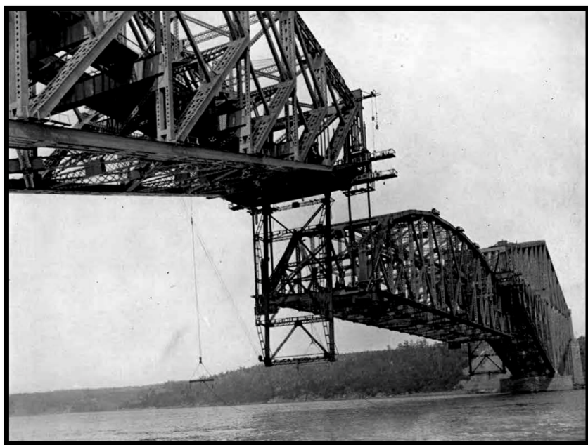
شکل ۴-۵- طره‌ی میانی پل کبک در حال بالا کشیده شدن جهت نصب (تصویر از دانشگاه برکلی)
